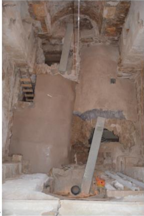
εικ. 57-60: Στερεώσεις και συμπληρώσεις στα εξωρράχια των θόλων του υπογείου -αρμολόγημα, επίχρισμα, πλήρωση με σκύρα μέχρι την στάθμη της υπόβασης του δαπέδου
