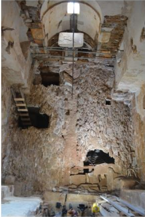
εικ. 57-60: Στερεώσεις και συμπληρώσεις στα εξωρράχια των θόλων του υπογείου -αρμολόγημα, επίχρισμα, πλήρωση με σκύρα μέχρι την στάθμη της υπόβασης του δαπέδου
