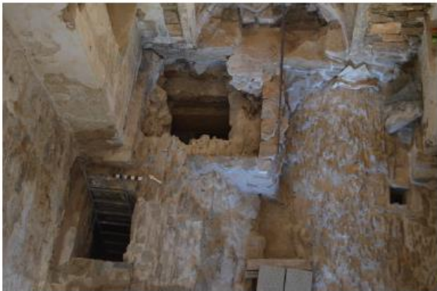
εικ.61-63: Λεπτομέρειες από τις στερωτικές εργασίες στα εξωρράχια των θόλων
