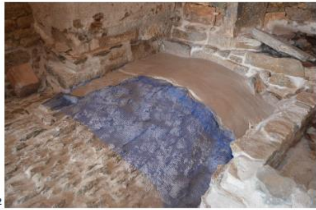
εικ. 57-60: Στερεώσεις και συμπληρώσεις στα εξωρράχια των θόλων του υπογείου -αρμολόγημα, επίχρισμα, πλήρωση με σκύρα μέχρι την στάθμη της υπόβασης του δαπέδου
