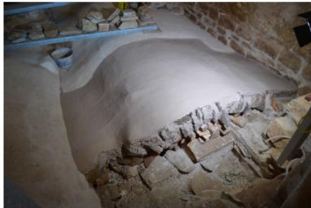
εικ. 57-60: Στερεώσεις και συμπληρώσεις στα εξωρράχια των θόλων του υπογείου -αρμολόγημα, επίχρισμα, πλήρωση με σκύρα μέχρι την στάθμη της υπόβασης του δαπέδου
