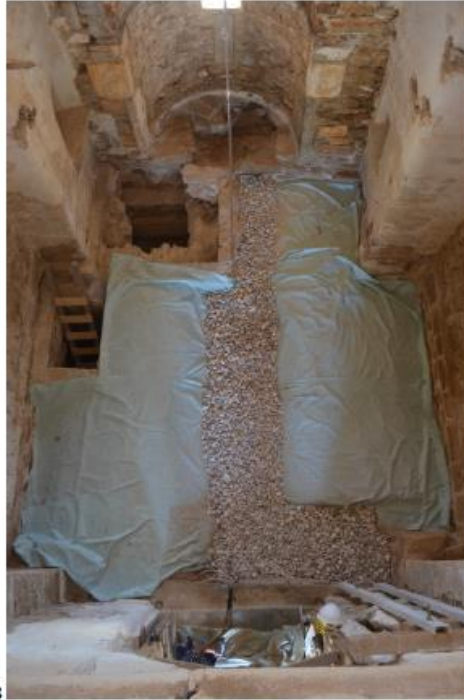
εικ. 57-60: Στερεώσεις και συμπληρώσεις στα εξωρράχια των θόλων του υπογείου -αρμολόγημα, επίχρισμα, πλήρωση με σκύρα μέχρι την στάθμη της υπόβασης του δαπέδου
