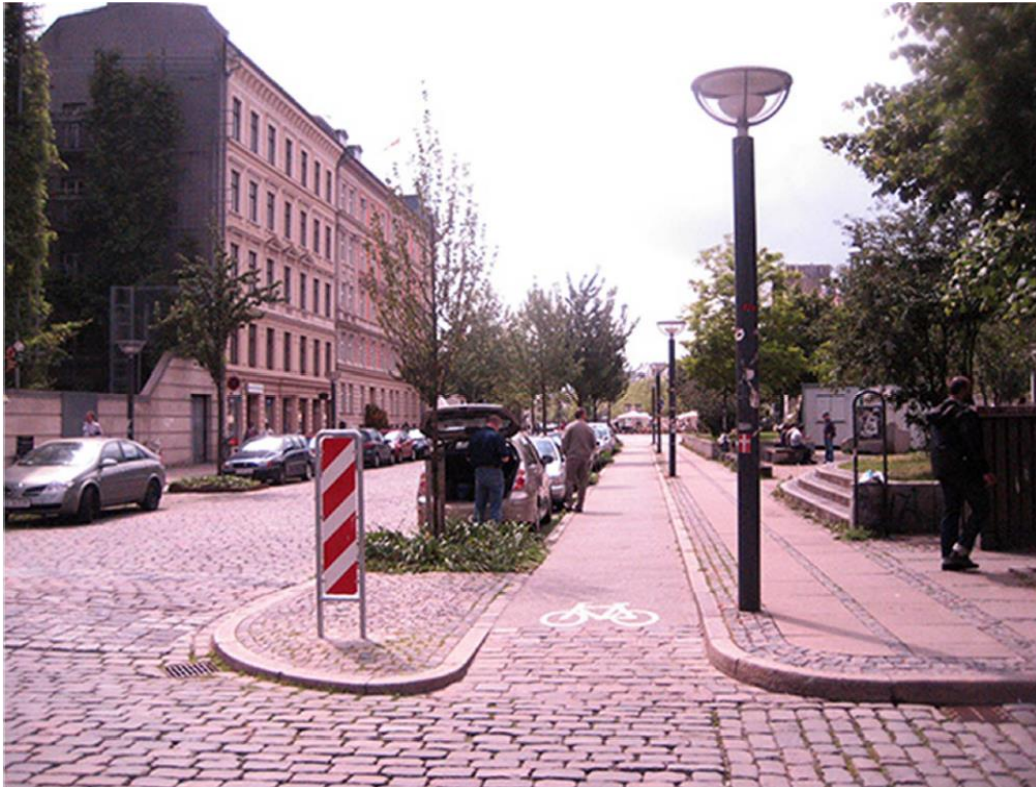
Εικόνα 200. Παράδειγμα διαμόρφωσης ποδηλατόδρομου στο επίπεδο του πεζοδρομίου οπτικά διαχωρισμένου από το πεζοδρόμιο
