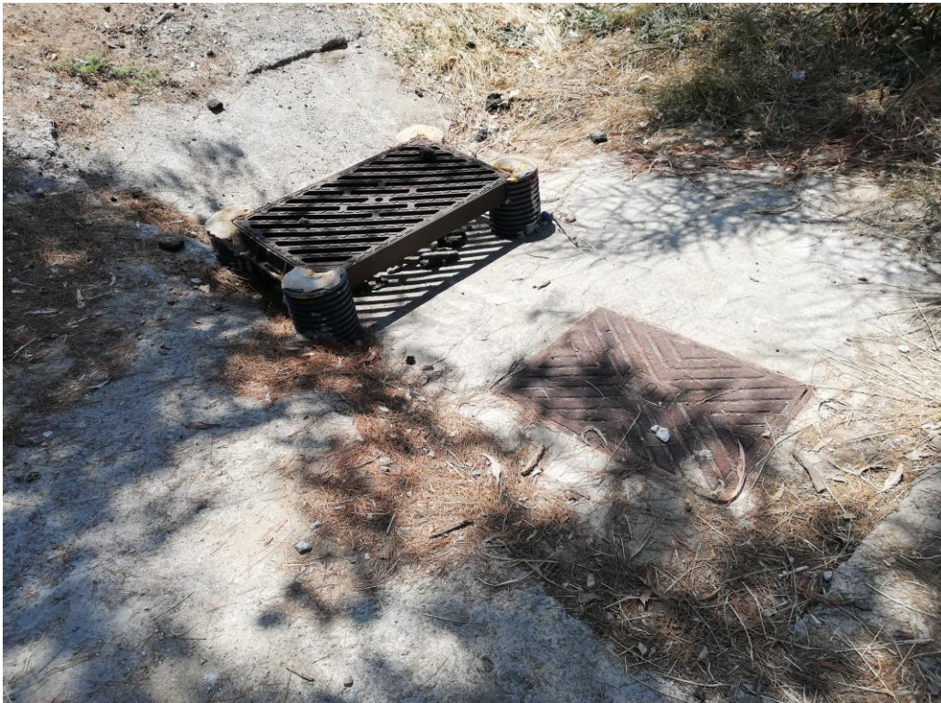
Εικόνα 164. Αντιπλημμυρικό έργο στη περιοχή μελέτης (αύξηση παροχευτικότητας υφιστάμενου φρεατίου)
