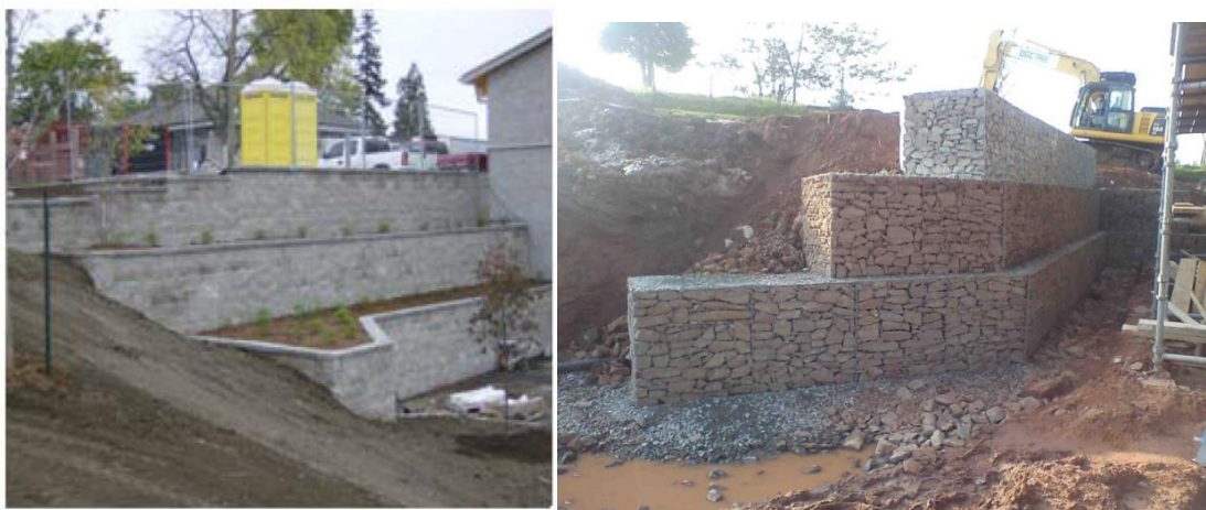
Εικόνα 175. Παράδειγμα εφαρμογής διάταξης αντιστήριξης με συρματοκιβώτια και λιθοδομή
