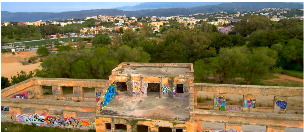
Εικόνα 135. Βόρεια όψη του κτιρίου Α των πρώην κατασκηνώσεων
