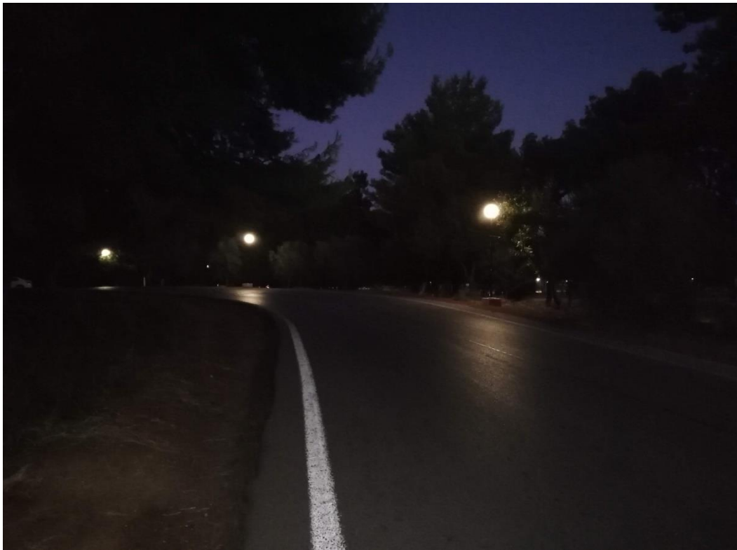
Εικόνα 166. Υφιστάμενος φωτισμός επί της οδού Αγίων Αποστόλων
