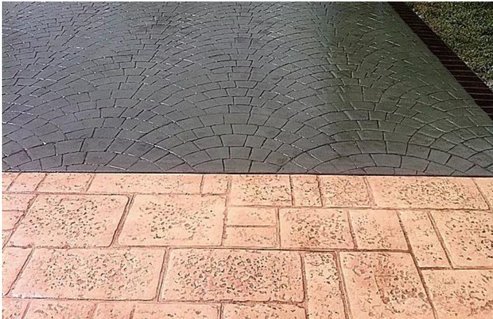
Εικόνα 199. Παράδειγμα διαμόρφωσης επιφάνειας με σταμπωτό σκυρόδεμα
