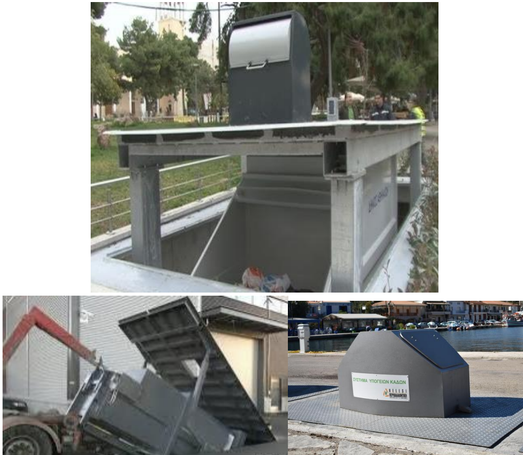
Εικόνα 231. Εποπτική εικόνα του πύργου τροφοδοσίας με τη βοήθεια του οποίου οι πολίτες απορρίπτουν στο απορριμματοκιβώτιο τα σύμμεικτα αστικά απόβλητα, καθώς και του συστήματος ανύψωσης του βυθιζόμενου απορριμματοκιβωτίου
