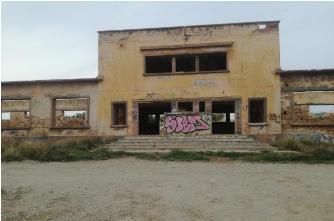
Εικόνα 134. Νότια όψη του κτιρίου Α των πρώην κατασκηνώσεων
